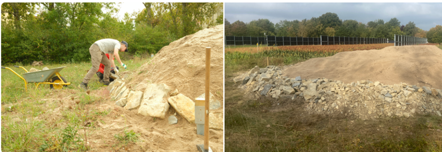
Abb. 4: Zur Sicherung des Sandhaufens kann der Rand mit ortstypischen Naturbruchsteinen umrandet werden. Hierfür kann grobes (links) oder feines (rechts) Gesteinsmaterial genutzt werden. (@ Y. Wehr)
