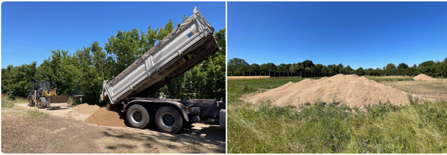
Abb. 3: Anlieferung von ungewaschenem Feinsand aus lokalem Abbau und Verteilung des Sandes mit einem Radlader. (@ Y. Wehr)
