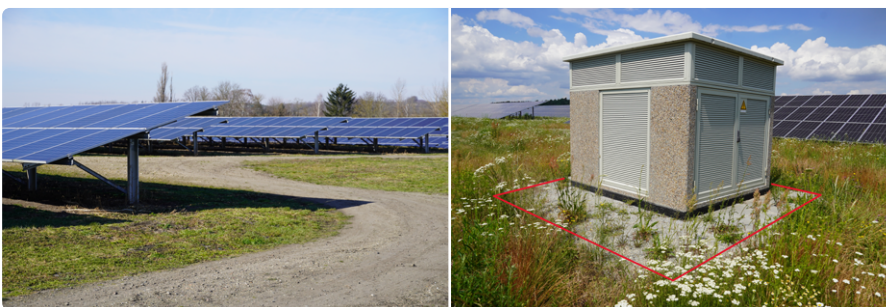
Abb. 1: Die geschotterten Wartungswegen und Freiflächen von PV-Anlagen eignen sich für die Einsaat von niedrigwüchsigen Schotterrasen (links). Im Bereich der Trafostationen (rechts) darf keine Einsaat erfolgen.
