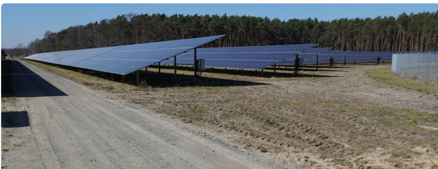
Abb. 2: Neu angelegter Schotterweg ohne Vegetation.
