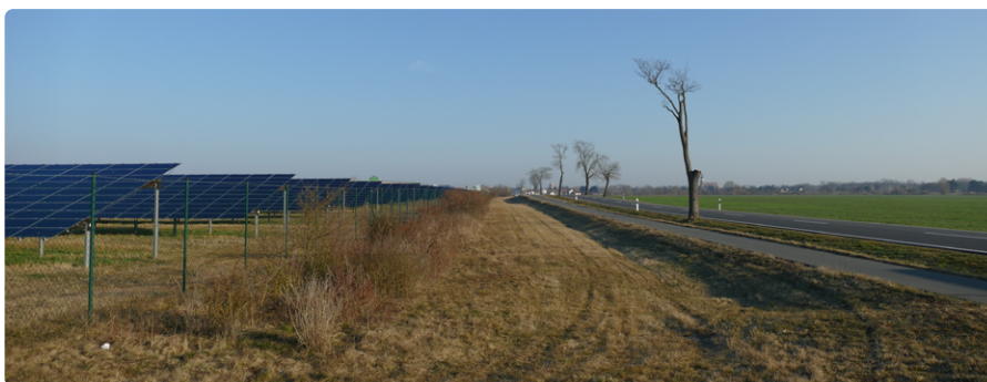
Abb. 3: Als Sichtschutz zur Straße angelegte zweireihige Heckenstruktur außerhalb einer PV-Anlage.
