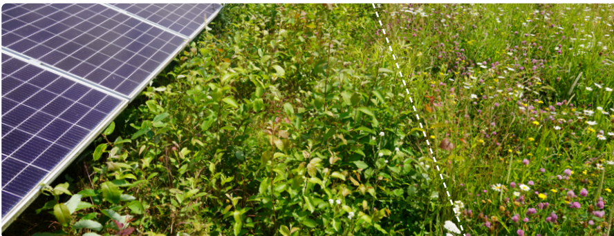
Abb. 1: Ein Meter vor den Solarmodulen wurde kein Wildpflanzensaatgut eingebracht. Während der restliche Modulreihenzwischenraum von niedrigwüchsigen Kräutern dominiert wird, konnten sich in dem Bereich ohne Einsaat Pappeln und Weiden ansiedeln.
