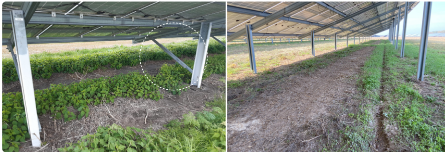
Abb. 9: Aufgrund der Querverstreibungen ist nur eine aufwendige motomanuelle Pflege möglich (links). Ohne Querverstreibungen ist der Einsatz effizienter Mähraupen und Aufsitzmäher möglich (rechts).
