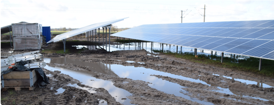
Abb. 4: Bei unzureichender Standfestigkeit des Bodens müssen die Bauarbeiten ruhen, um langfristige Schäden der Bodenstruktur und Verdichtungen zu vermeiden.
