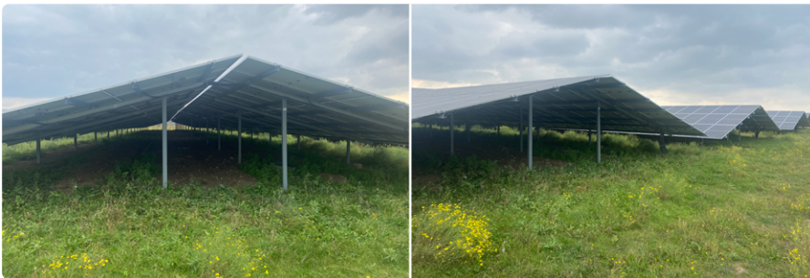
Abb. 6: Ost-West ausgerichtete PV-Anlagen erzeugen großflächige und intensive Beschattungen und sind aus naturschutzfachlicher Sicht abzulehnen.
